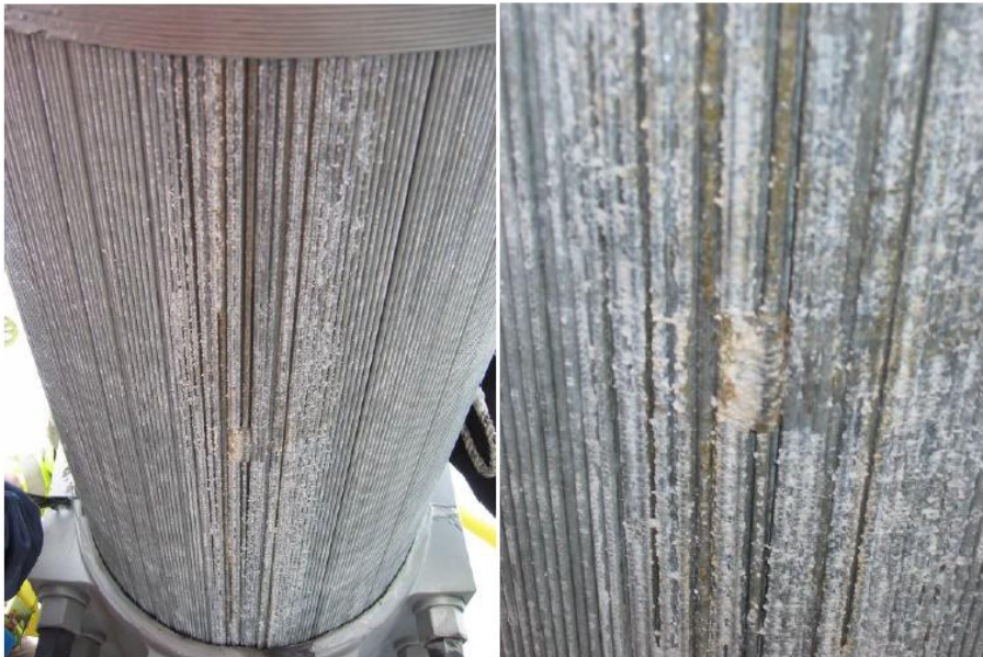
Undersida av sydliga huvudkabeln vid mittlås, september 2004
